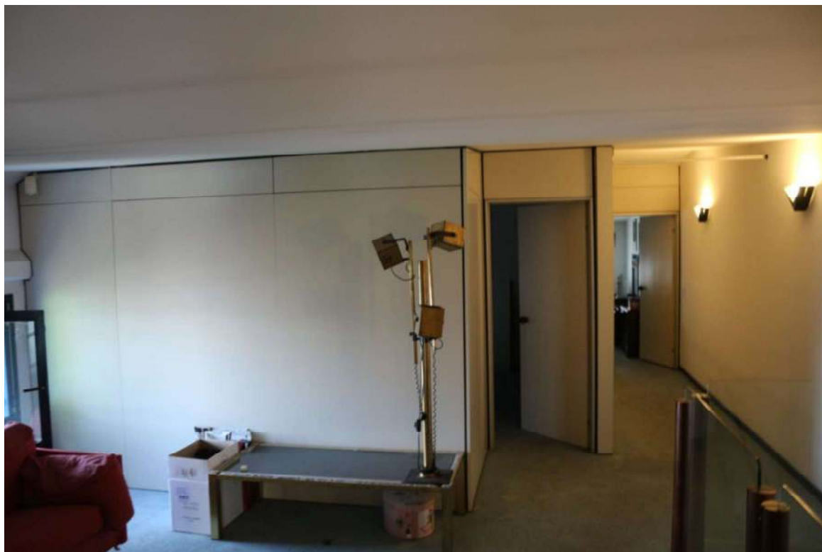
FOTO N°5.- visione esterna - AREA UFFICI
